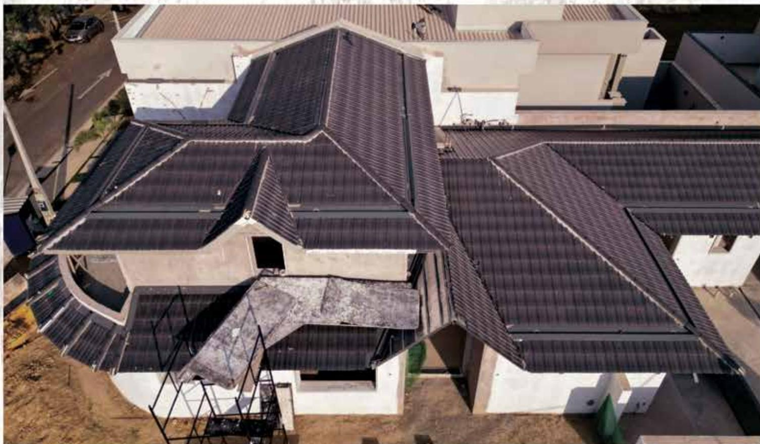
ESTRUTURA TELHADO COM TELHAS DE CERÂMICA E MANTA TÉRMICA
