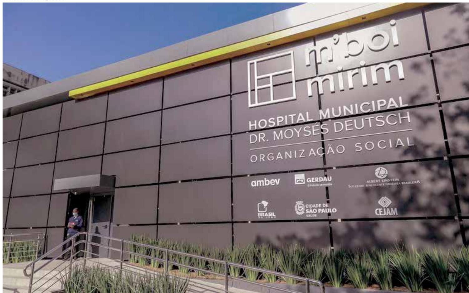
*O anexo do Hospital Municipal M'Boi Mirim foi construído a partir de técnica de construção modular off-site BR3. Foram 70 módulos, ou seja, 70 partes que se encaixam perfeitamente entre si*
