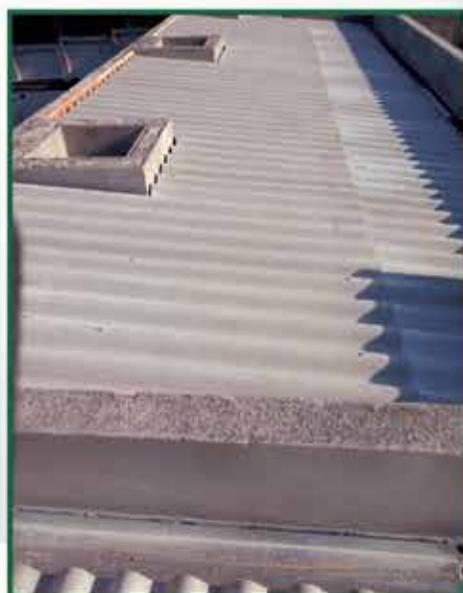
Estrutura embutido com telha fibrocimento
