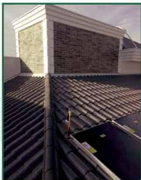
Estrutura ripado com laje e telha tipo cerâmica
