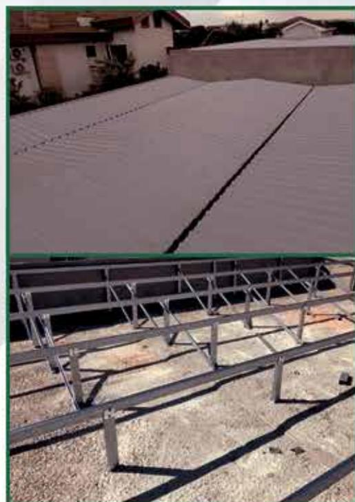
Estruturas embutido com laje - com telha sanduiche
