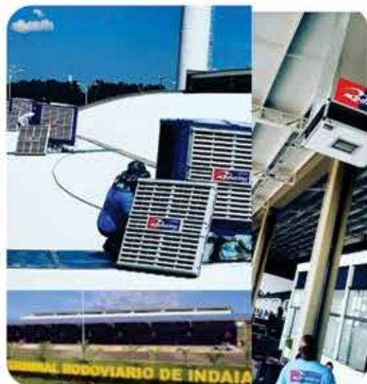
A climatização evaporativa Reduzino é uma solução inovadora para climatização e renovação do ar dos ambientes. Seu sistema de climatização opera por meio da evaporação de água, que reduz a temperatura e umidifica o ar do ambiente e o renova de forma constante, enquanto simultaneamente acontece a filtragem de impurezas.
