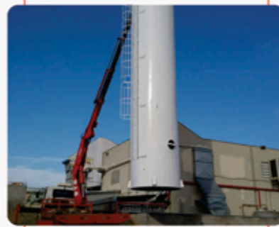
Fabricação de Caixa D'água Metálica
