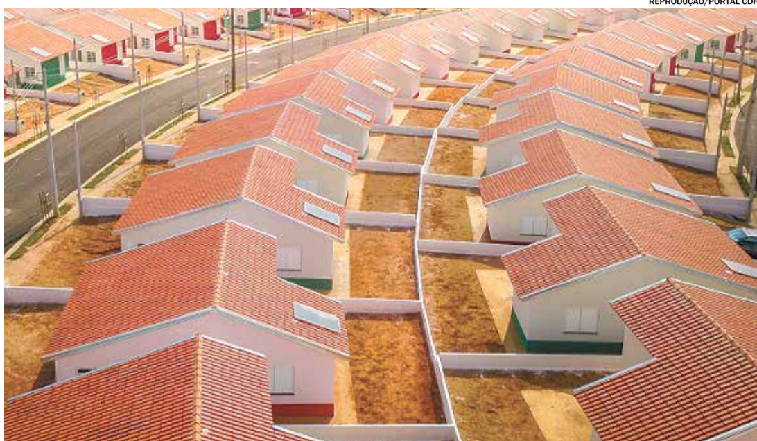
Em Capivari o projeto contempla a construção de 200 unidades
