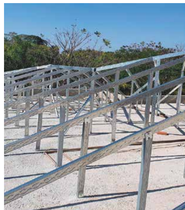
Mais uma obra realizada pela Mr Roof, telhado telhas tegula Itu. A Mr. Roof, estruturas para telhados em aço galvanizado, trabalha com orientação na execução da montagem ou entrega seu telhado pronto. Telhados embutido para uso de telhas galvanizadas, fibrocimento e também telhados com telhas cerâmicas. Mr Roof – inovação em telhados. Faça seu orçamento sem compromisso estamos atendendo on line e via WhatsApp F. (19) 98355-8383, comercial@mrroof.com.br. A MR. Roof está em novo endereço na Rua: Edesio Capovila, 159 – Jardim Esplanada.
