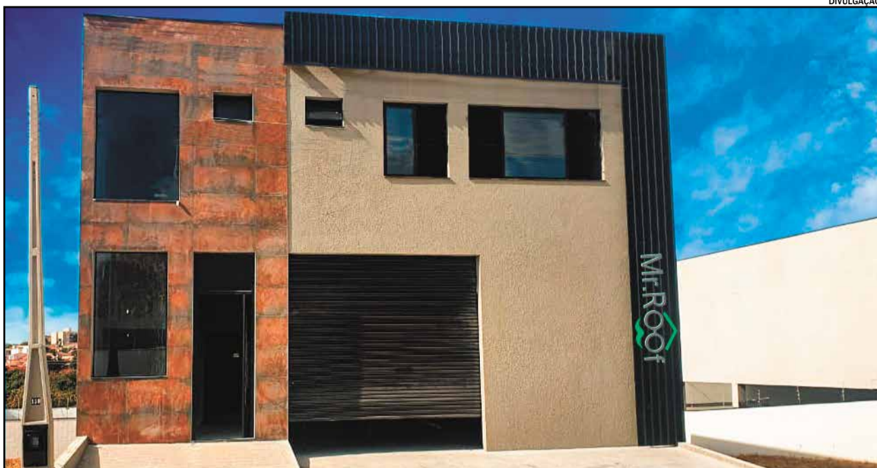
Mr. Roof acaba de montar escritório comercial e showroom mais amplos para atender ao cliente
