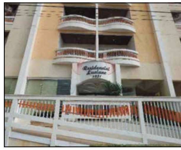
11 ref 27457 - Apartamento Vila Georgina- 3 dorm, coz , banheiro, lavanderia e garagem - R$ 450.000,00 + Cond + IPTU
