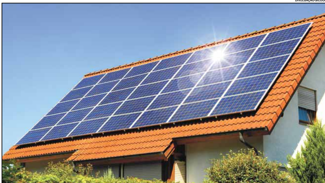
A economia gerada com a implantação do equipamento é de até 95% na conta de luz
