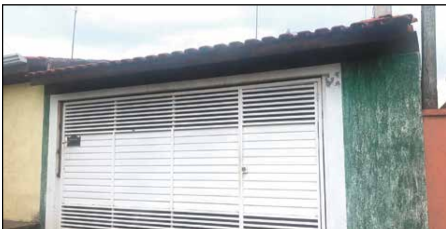
CASA VENDA JARDIM MORADA DO SOL FRENTE:02 DORMITÓRIOS,COZINHA AMERICANA,WC FUNDOS : 02 CÔMODOS, WC GARAGEM PARA DOIS AUTOS COM PORTÃO ELETRÔNICO DE R$210.000,00 POR APENAS R$180.000,00
