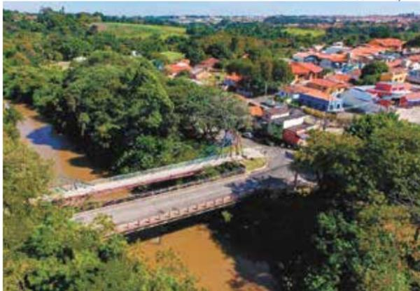
A passarela metálica de pedestres e ciclistas, instalada sobre o Rio Jundiá, será removida para dar lugar a uma nova ponte de concreto. A obra faz parte do projeto de requalificação da Alameda Coronel Antônio Estanislau do Amaral, em Itaici, que já está em execução. Em boas condições, a ponte será realocada no Parque Ecológico, ainda sem local definido.
