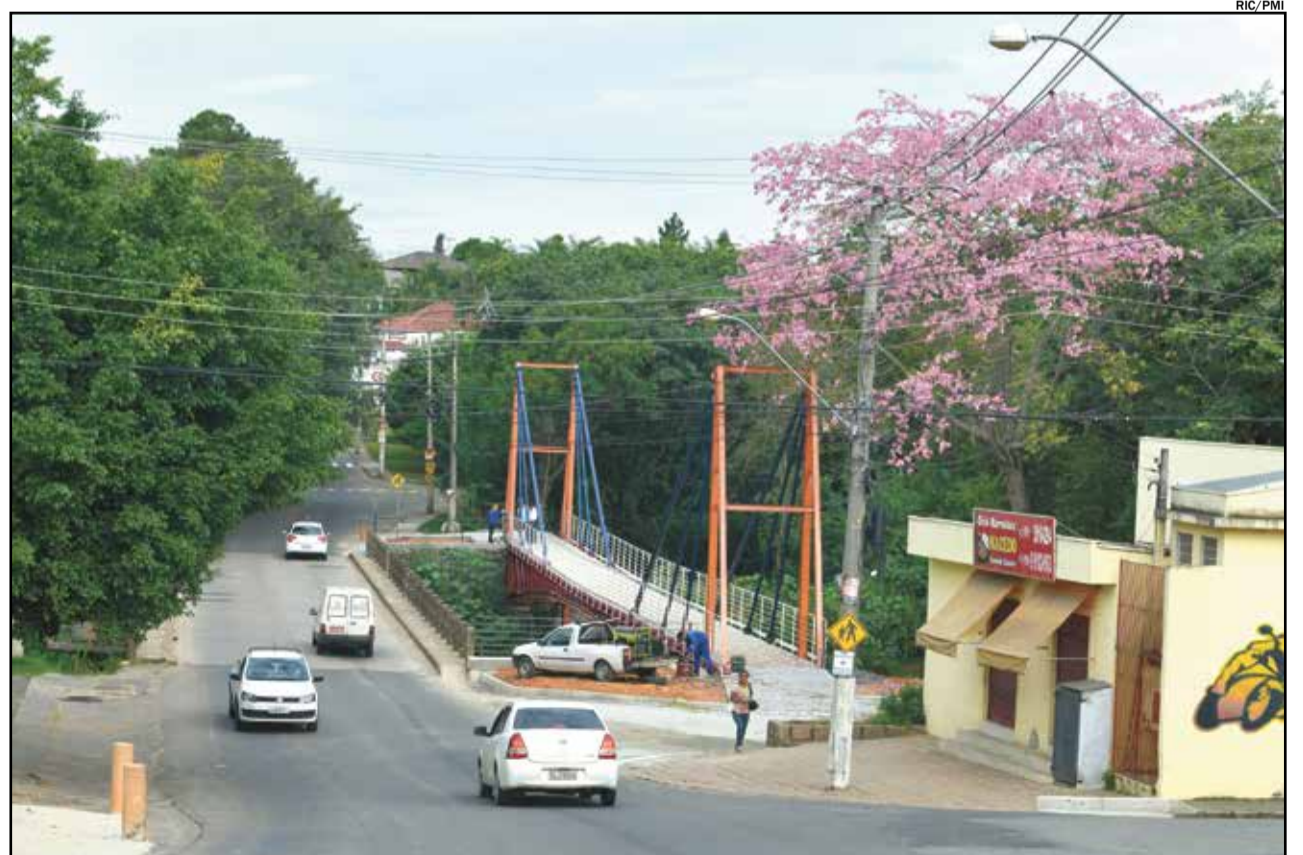
Uma nova ponte será construída, sentido centro-bairro, com duas faixas de rolamento
