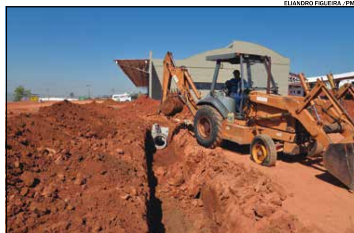
A previsão é de que a pavimentação esteja pronta até o final de outubro
