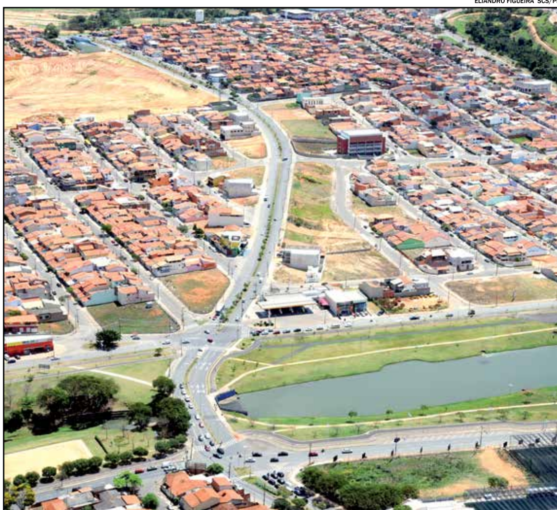
Prefeitura emite ordem de serviço para construção do primeiro elevado de Indaiatuba
