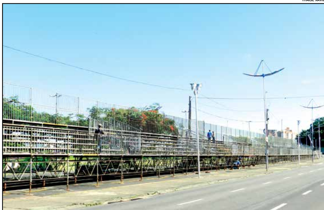
Estrutura já está montada na marginal do Parque Ecológico
