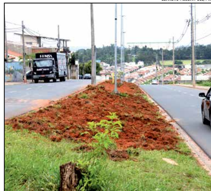
Remodelação foi necessária para evitar riscos de acidentes
