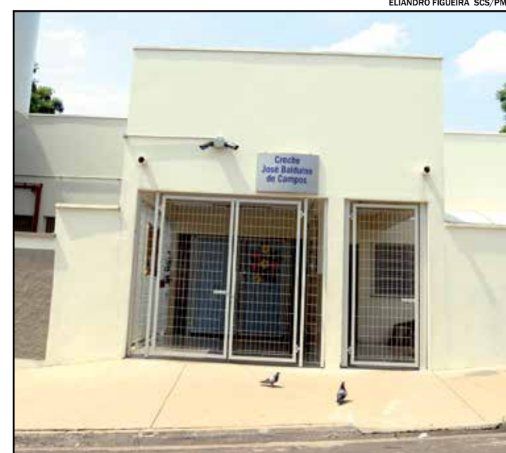
Obra já estava pronta, mas faltava ligação da CPFL
