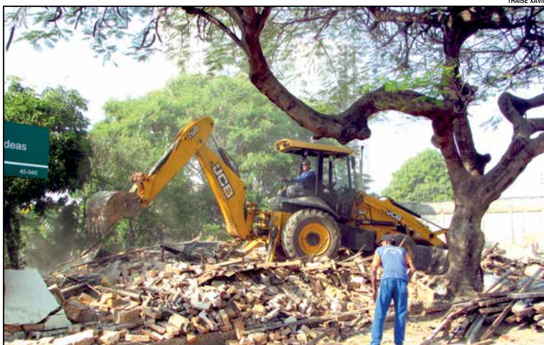
Demolição das casas aconteceu no início da semana
