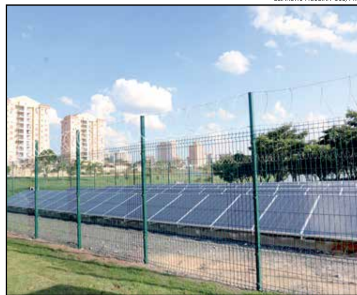
Instalação do painel foi concluída no final de agosto
