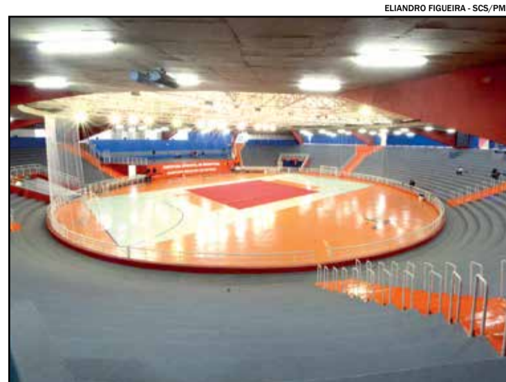
Ginásio Municipal de Indaiatuba foi totalmente reformado
