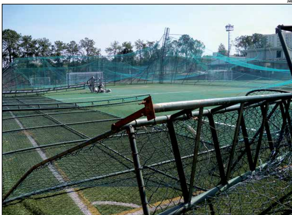
Toda estrutura dos campos do Deco 20 foi danificada por conta da força do vento, que chegou a 30 km/h
