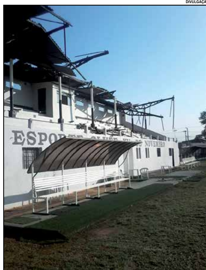
Chuva destelhou a cobertura do estádio XV de Novembro
