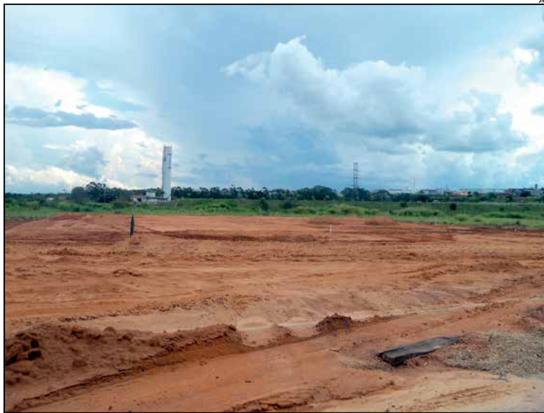
Terraplanagem está sendo feita na área em que se instalará a subestação da CPFL
