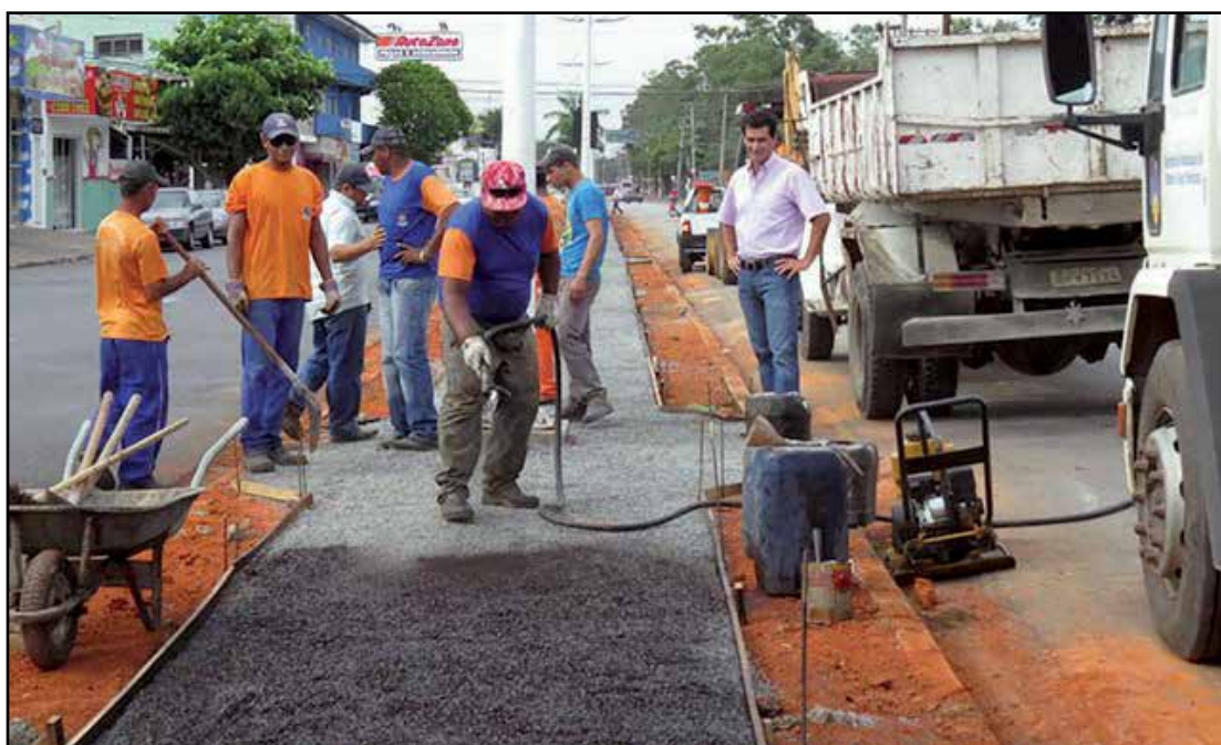
Obras da ciclovia na Avenida Francisco de Paula Leite estão quase concluídas
