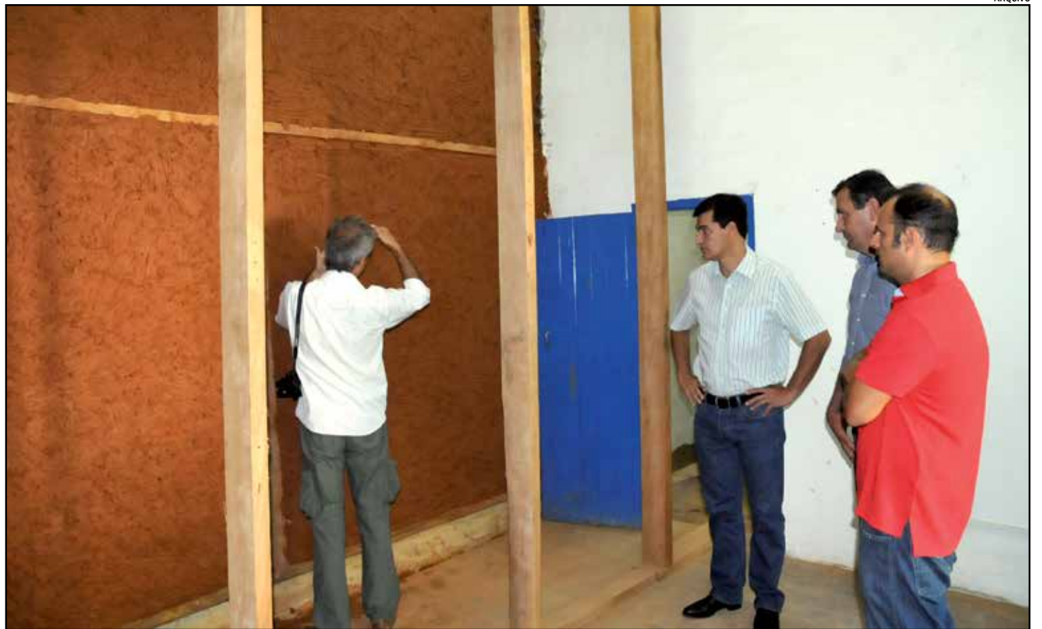
Reinaldo Nogueira, José Carlos Selone e o superintendente da Fundação acompanham obras no Casarão Cultural durante processo de restauração
