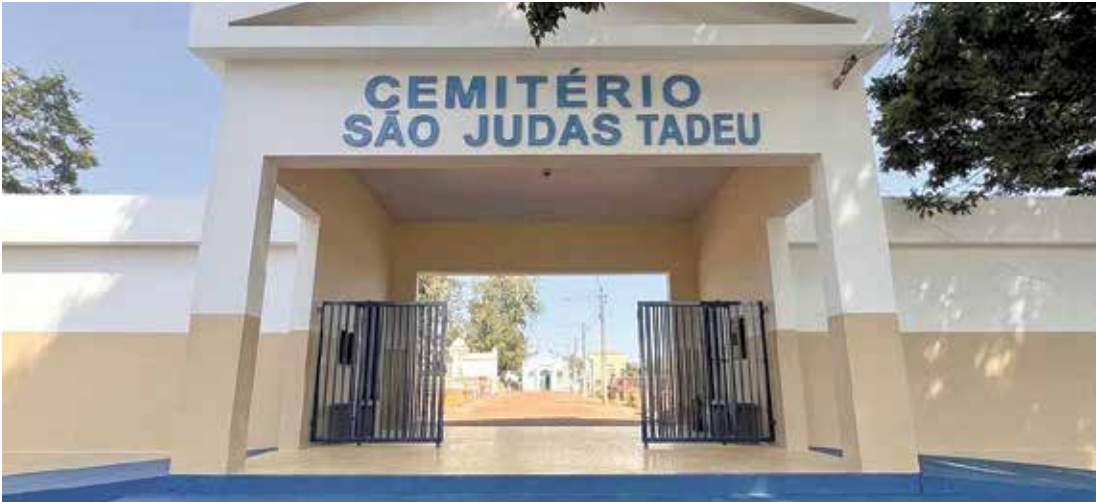
Obras incluem melhorias na fachada, nos banheiros, nas salas de atendimento e na capela
