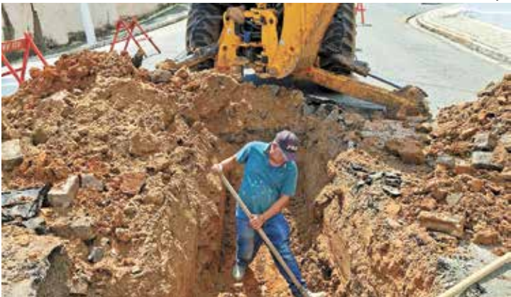
CHUVAS Itu realiza reparos em galerias pluviais para recuperar redes e melhorar o escoamento Pág. A10
