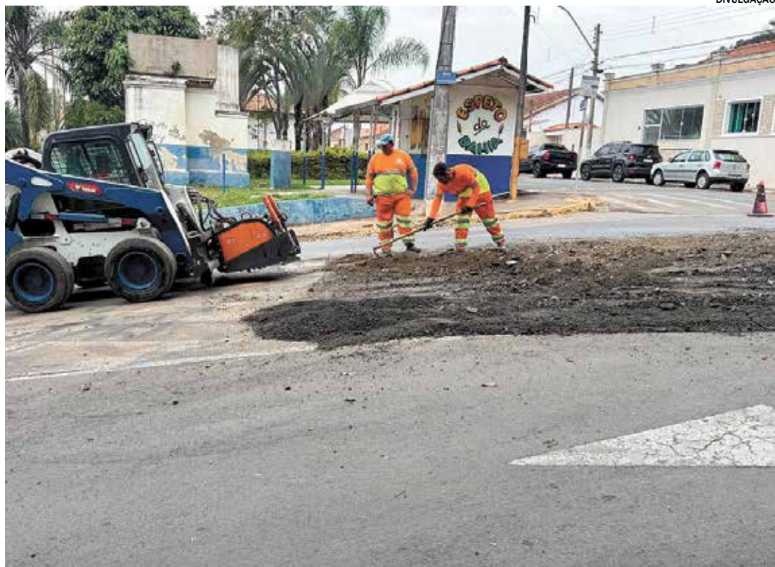
A operação faz parte das ações da Administração Municipal voltadas à manutenção das vias
