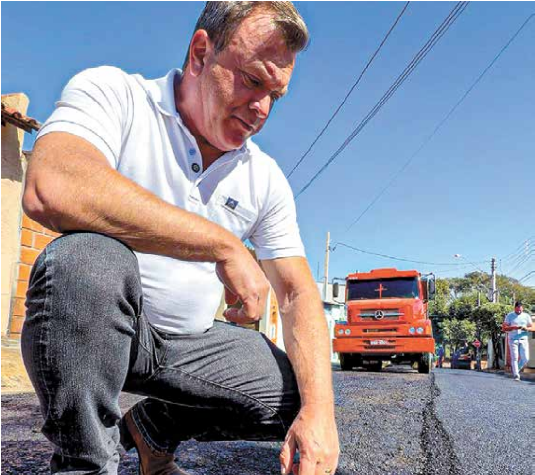
O recapeamento integra as ações da Administração voltadas à recuperação e melhoria da malha viária
