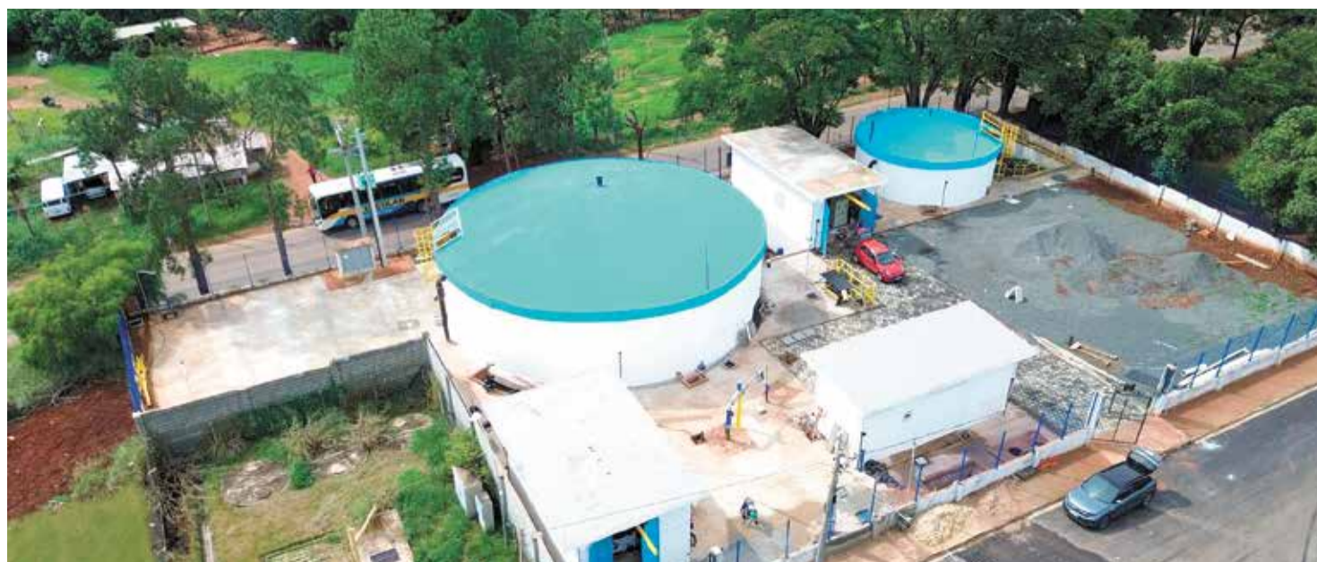
O reservatório faz parte das obras que foram desenvolvidas em parceria com a Prefeitura de Elias Fausto, o DAAE, o Grapohab, a CETESB e Sabesp
