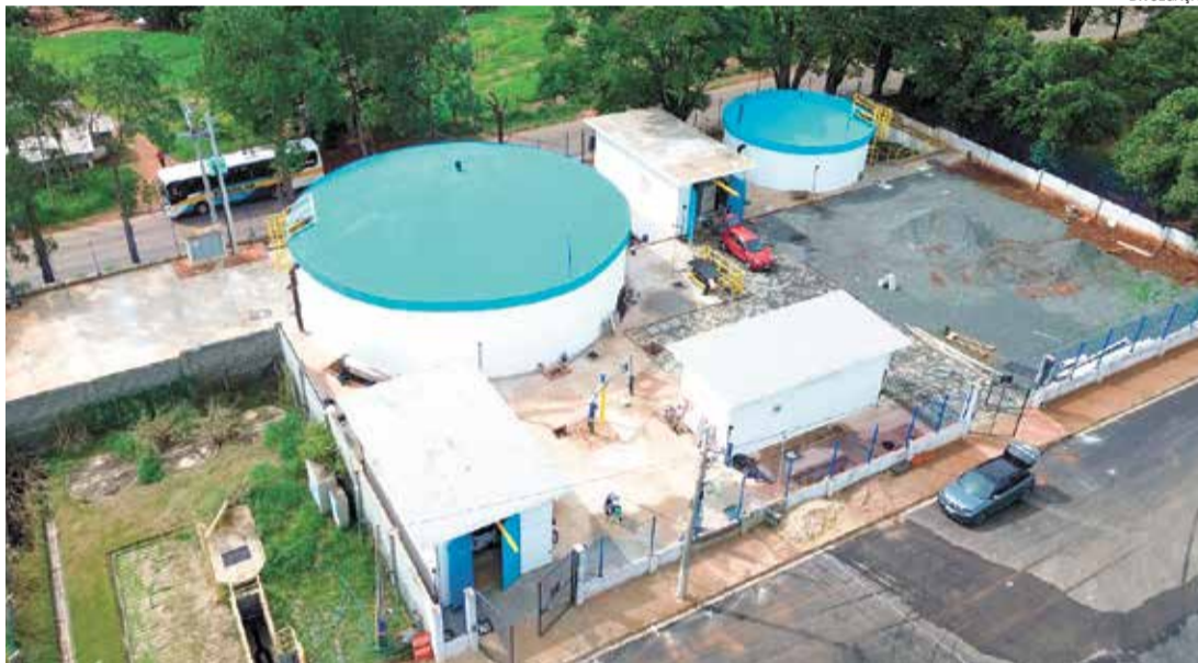
A Cardeal Saneamento implementou rede de esgoto, elevatórias e Estação de Tratamento de Esgoto
