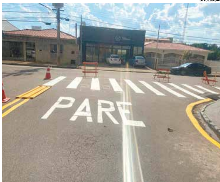
Os serviços seguiram na região da Rodoviária no início da semana
