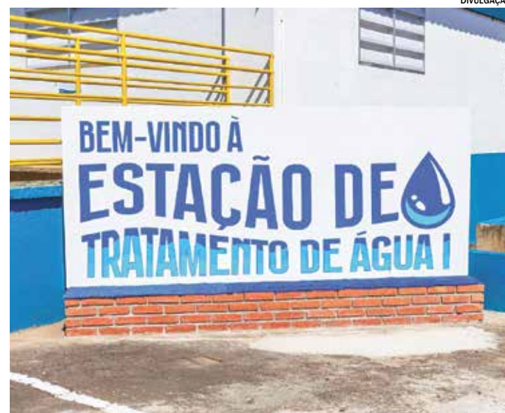
Obra reforma bombeadores e moderniza todo o laboratório
