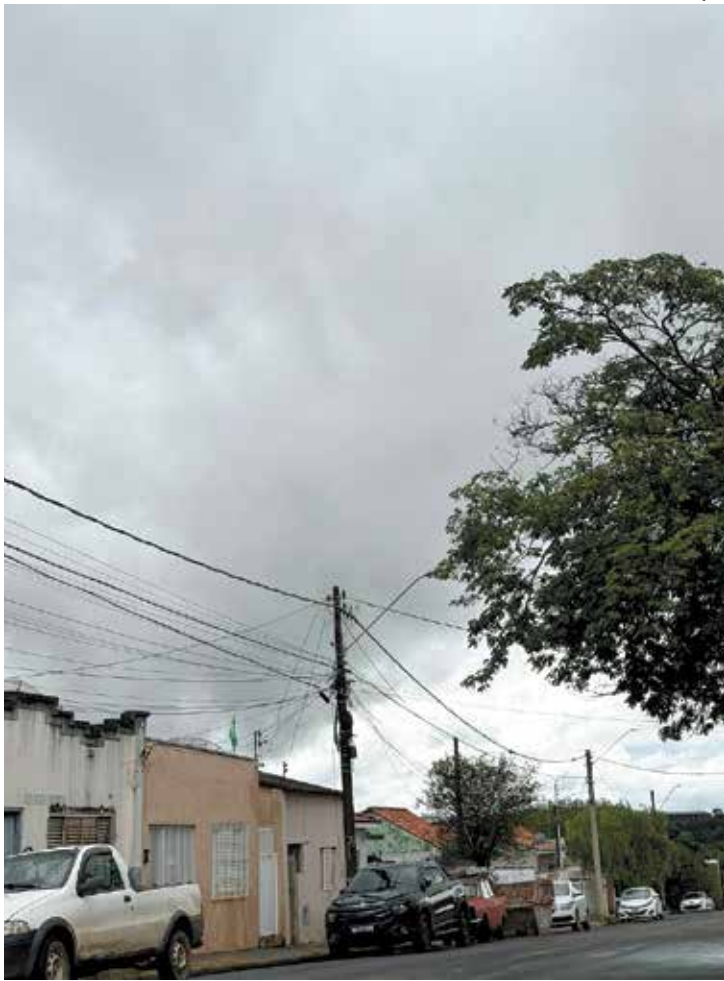
Prefeituras têm mobilizado equipes para realizar a manutenção
