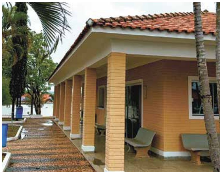
O muro externo foi totalmente reconstruído e recebeu nova pintura
