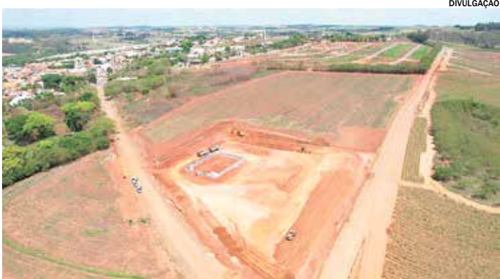
Obras da subestação de energia
