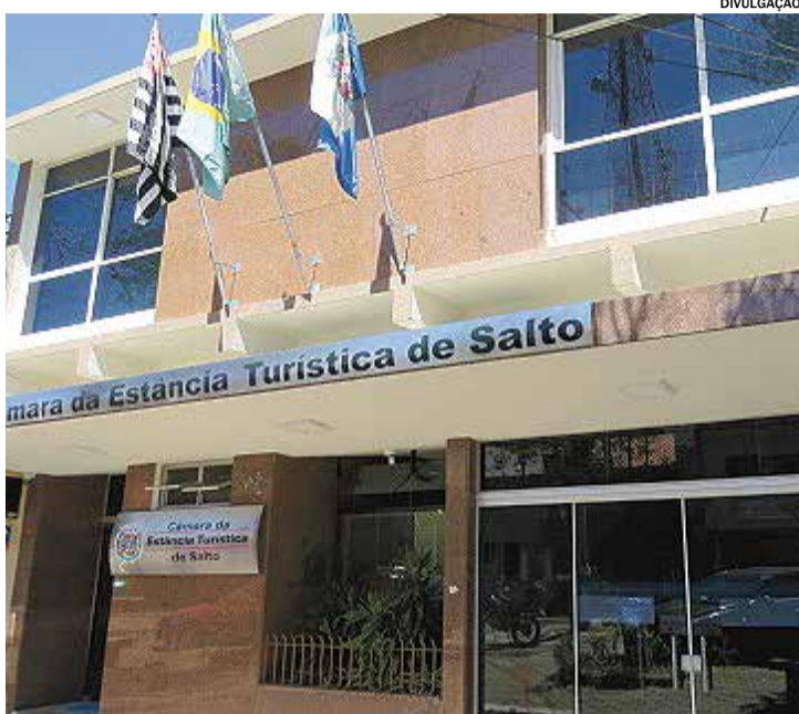
O objetivo de viabilizar a construção da nova sede do Posto de Bombeiros
