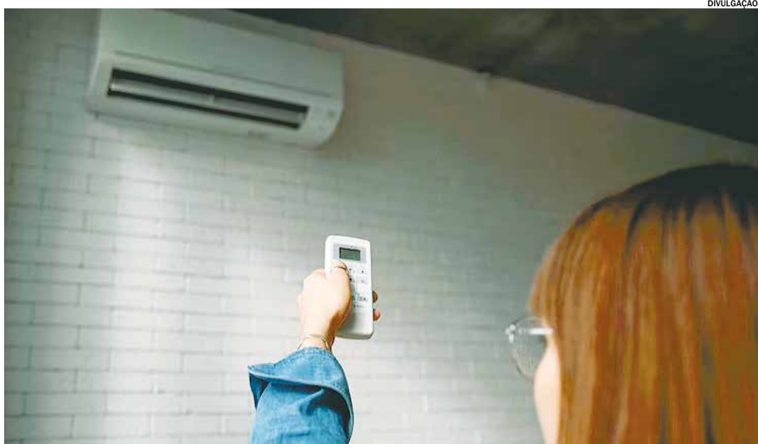
É fundamental adequar a rede elétrica ao instalar equipamentos fundamental adequar a rede elétrica
