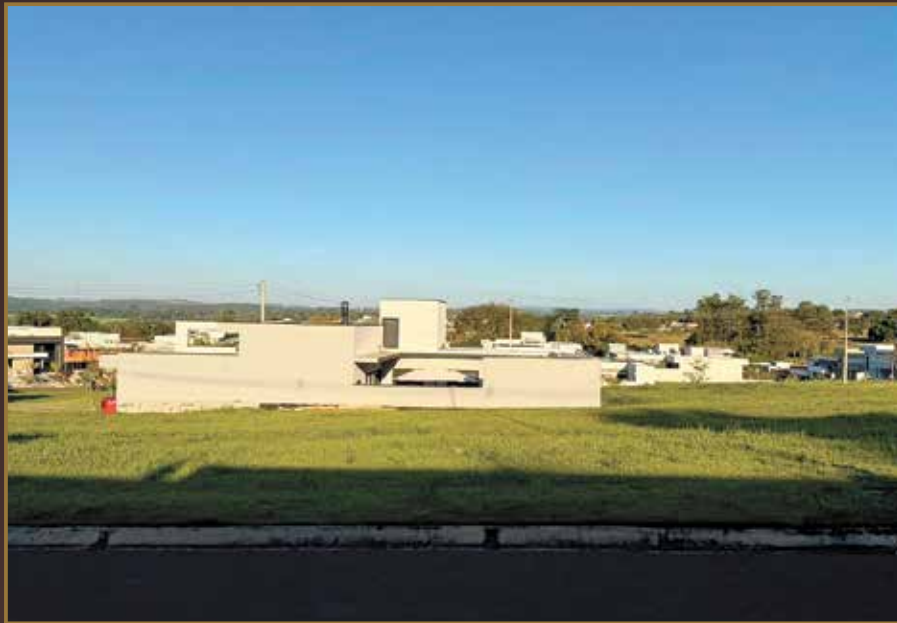
TERRENO RESIDENCIAL CONDOMÍNIO LONDON PARK - ÁREA: 300 M² (12 X 25 M) - R$ 470.000,00
