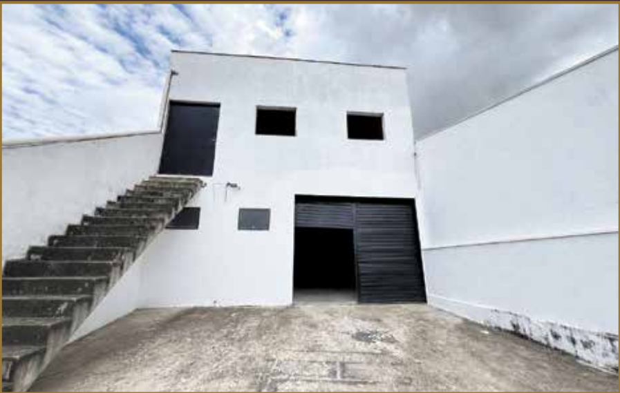
SALÃO COMERCIAL JARDIM CAMPO BONITO - ÁREA DO TERRENO: 150,00 M² / ÁREA CONSTRUÍDA: 210,00 M² - 02 BANHEIROS / COZINHA / ESCRITÓRIO / ÁREA DE LUZ / PAVIMENTO SUPERIOR COM ACESSO INDEPENDENTE PELA PARTE EXTERNA - VALOR DO IMÓVEL: R$ 390.000,00
