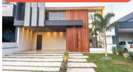
CA0865 – Residencial Evidências
