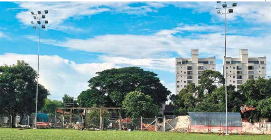
Secretaria de Obras implantou sistema de iluminação com a instalação de seis postes de 15 metros
