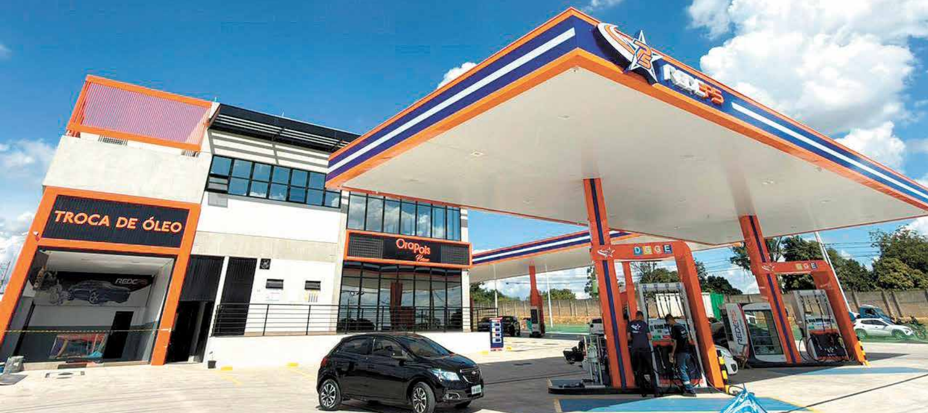
Mais do que um ponto de abastecimento, o empreendimento foi concebido como um complexo comercial, reunindo diferentes serviços em um único espaço em Indaiatuba
