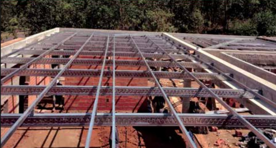
**ESTRUTURAS PARA TELHADO DE AÇO GALVANIZADO**
