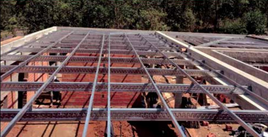
**ESTRUTURAS PARA TELHADO DE AÇO GALVANIZADO**
