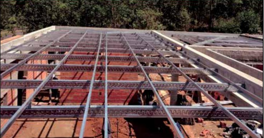
**ESTRUTURAS PARA TELHADO DE AÇO GALVANIZADO**
