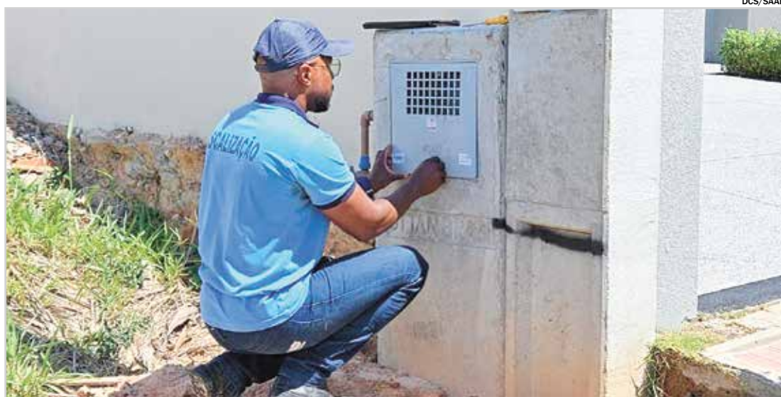
O novo padrão protege o hidrômetro das intempéries e da ação do tempo, aumentando a durabilidade do equipamento
