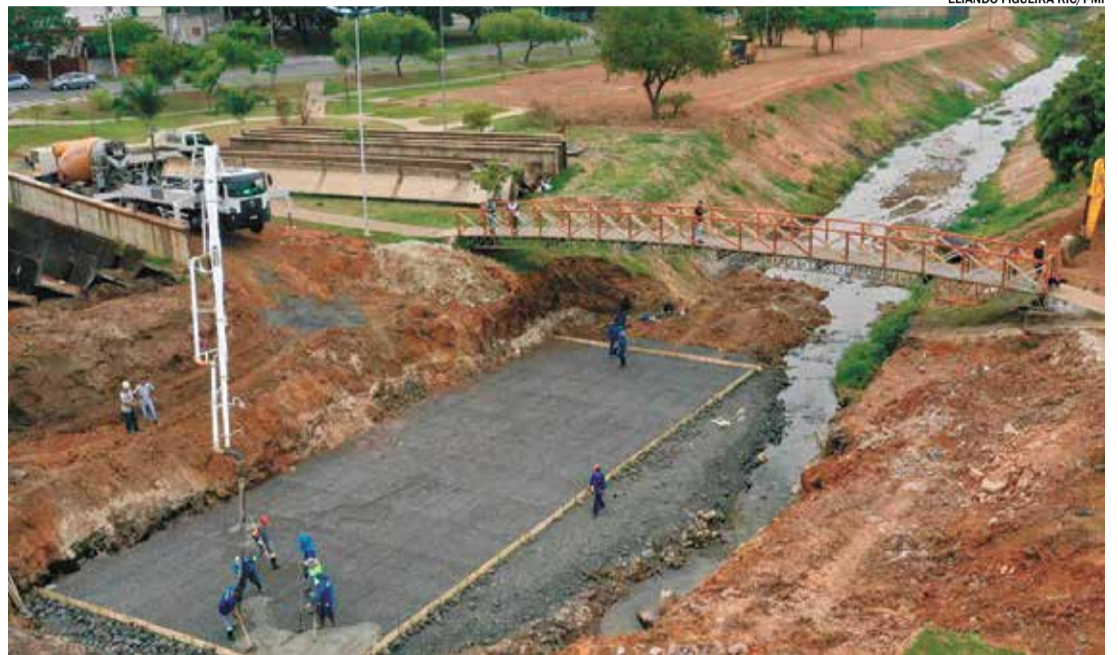
Secretaria de Obras e Vias Públicas trabalha na base da travessia de aduelas que será implantada no local
