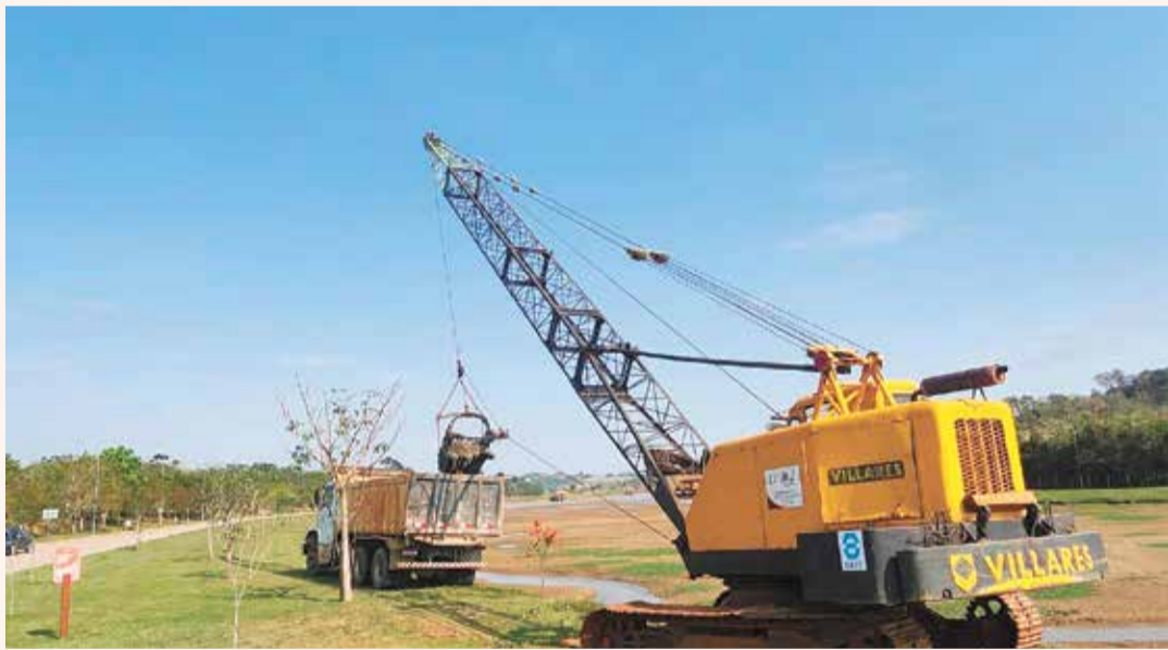
Máquinas começaram trabalhos de desassoreamento no dia 29; obra deve levar de três a quatro meses
