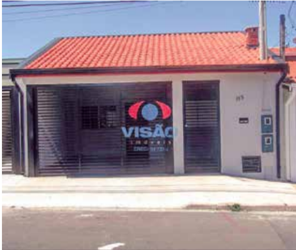
1 ref site 6875 - Casa Jardim Alice - 2 dorm , sala, coz, banheiro, área de serviço R$ 2.200 + IPTU
