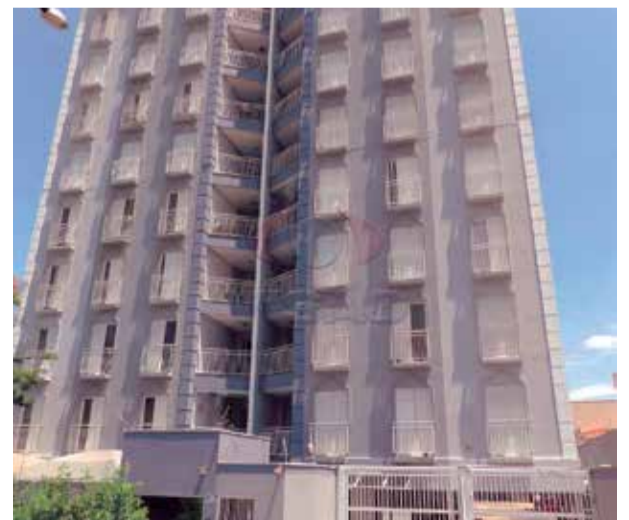
12 ref site 33082 - Apartamento Jardim Santiago - 3 dorm, suite, coz, sala, banheiro, área serviço e garagem - R$ 440.000,00
