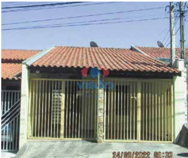
1 ref site 3150 - Casa Jardim Primavera - 2 dorm , sala, coz, banheiro, área de serviço R$ 1.500,00 + IPTU
